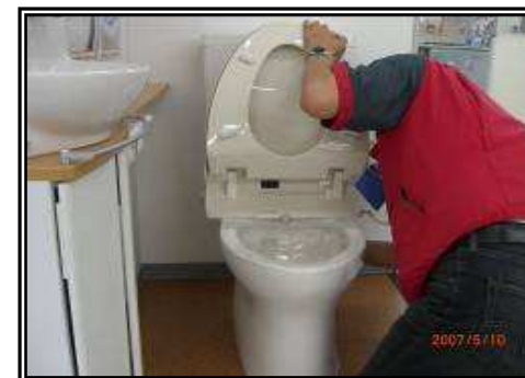
当社従業員による小型物件の工事
